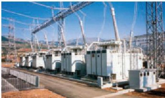
Рис. 13.1. Повышающий трансформатор
