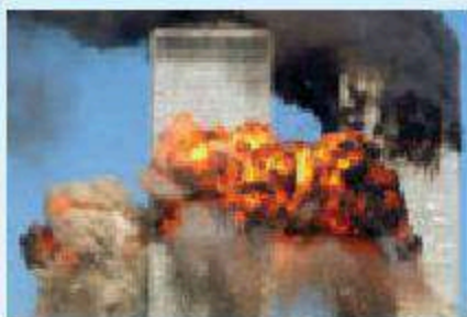
Рис. 34. Разрушение Всемирного торгового центра США
