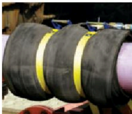
25-сурет. Құбырдың түйіскен жеріндегі резеңке құрсау
