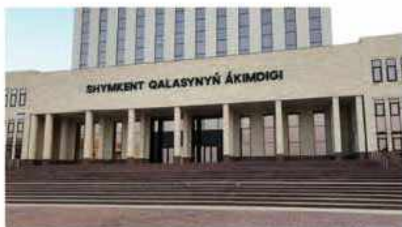
Здание областного акимата
