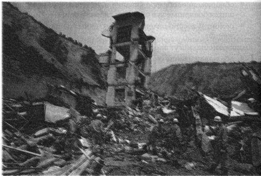
Рис. 43. Аварийно-спасательные работы после обрушения здания
