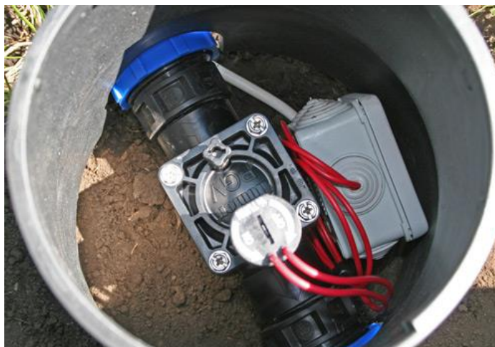
Рис. 99 Установка клапана для автополива
