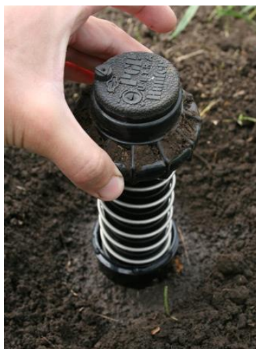
Рис. 107 Демонтаж механизма без выкапывания спринклера целиком
