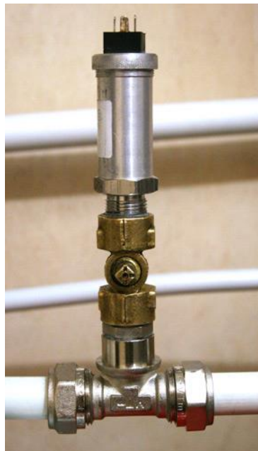
Рис. 103 KPT-9 смонтирован на металлопластик
