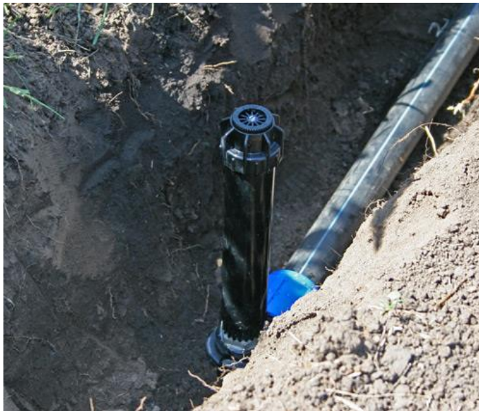
Рис. 105 Установка спрея Hunter PS Ultra
