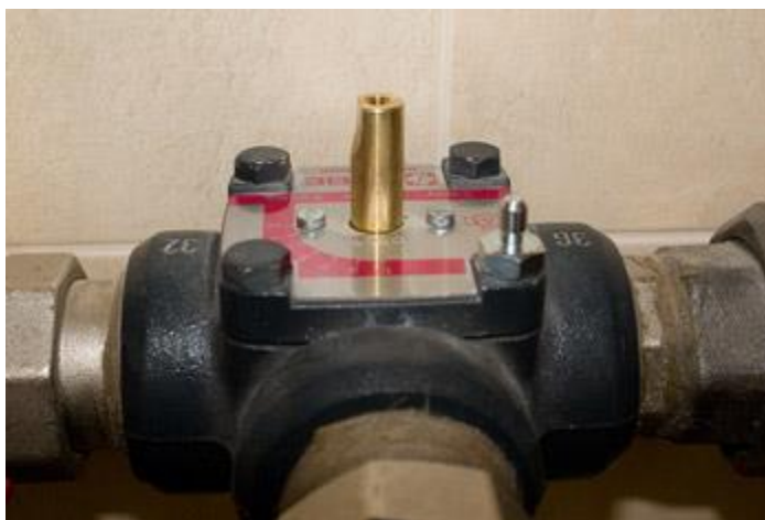
Рис. 48 Вот так предлагает делать фирма ESBE для 3-х ходовых серии 3G
